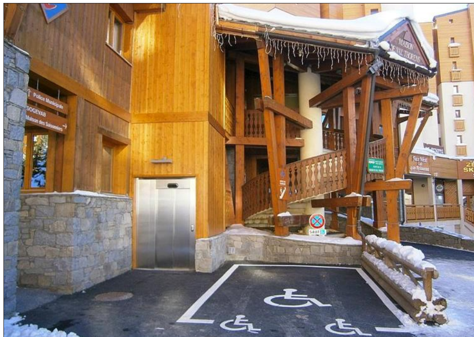
Batisafe a été maître d'œuvre pour mettre la maison de Val-Thorens en conformité avec l'accessibilité aux personnes handicapées : ascenseur, place de stationnement adaptée et signalétique. Photo DR
